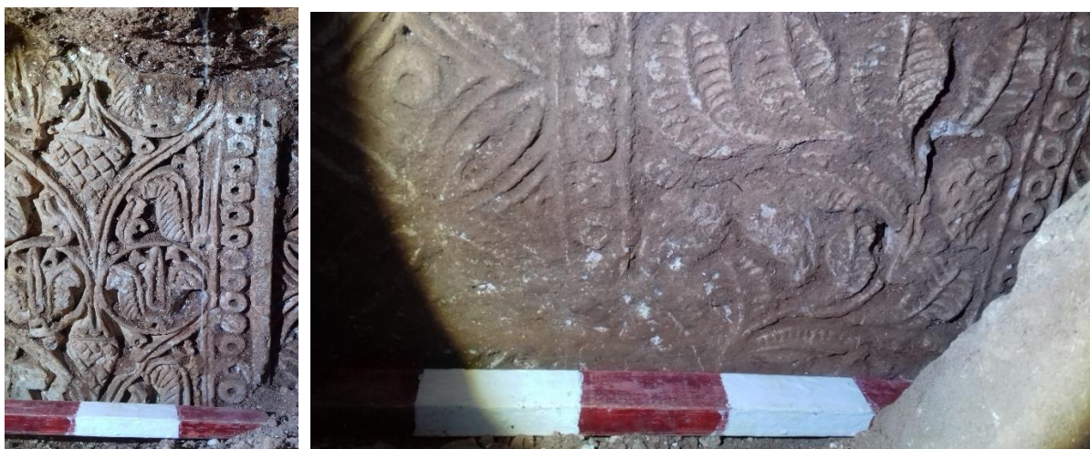
شکل ۷. نمای نزدیک نقوش قاب‌بند A (سمت چپ) و قاب‌بند B (سمت راست) از ازاره شمالی بنای گنبددار قلعه‌سام. منبع: نگارندگان.
