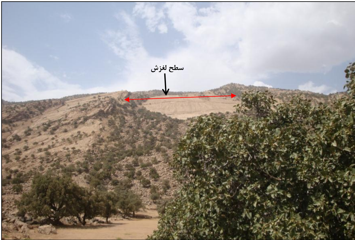
شکل ۵: سطح لغزشی چلوار Fig 5: Cholvar sliding surface
